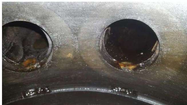
Рис. 2 Дефекты в корпусе ПСМ
